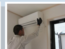
エアコン故障取替え
